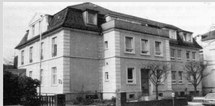
Verwaltungsgebäude des GUV Oldenburg
