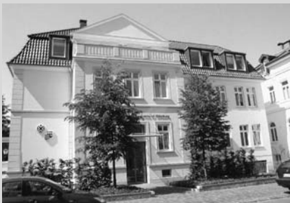
Verwaltungsgebäude nach dem Umbau
